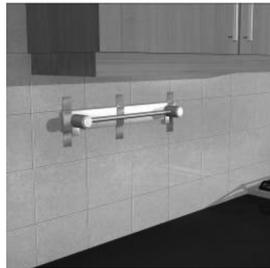
Durante el curado/ endurecimiento debe mantenerse la posición de la pieza a pegar con respecto al soporte. Cualquier movimiento podría destruir la superficie de pegado (tenga en cuenta la temperatura y los tiempos de curado relacionados, tiempos durante los cuales puede ser necesaria una sujeción adicional).
